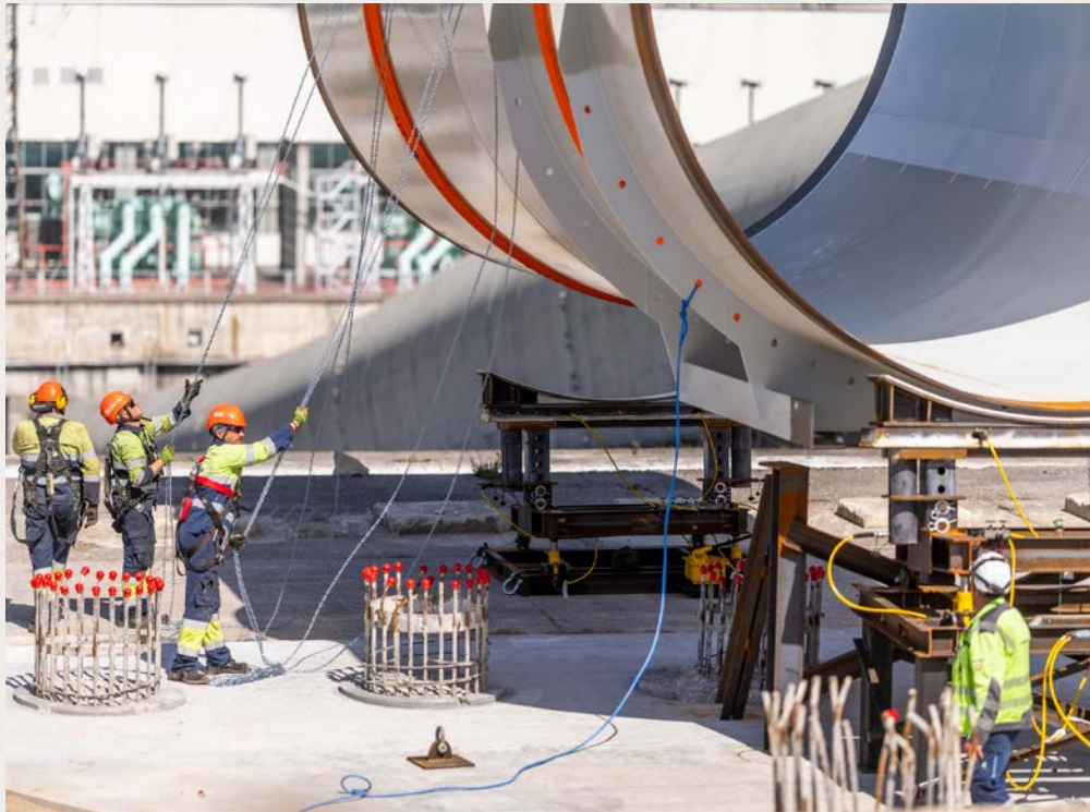
Naują agregatą sudarys 75-ios vamdyno sekcijos. Vienos sekcijos ilgis siekia 12 metrų.
